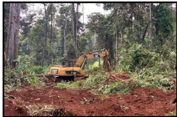
Gambar 2. Proses kegiatan pembuatan jalan tambang ( land clearing )
