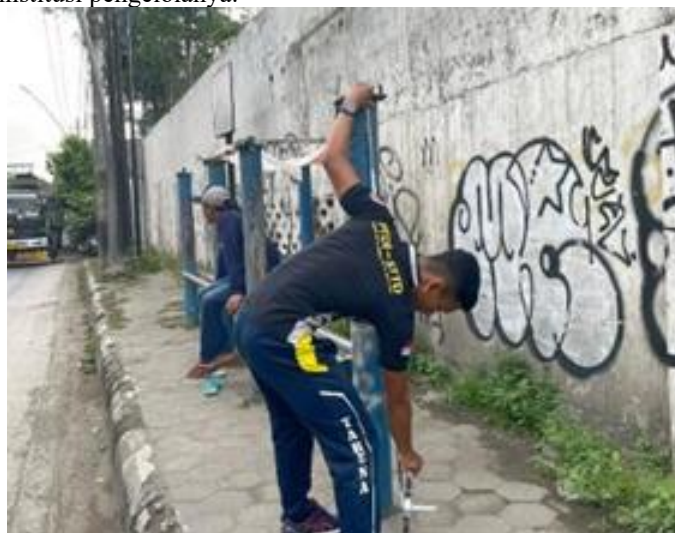
Gambar 3. Kondisi Halte Martoloyo 2 dengan atap yang telah ambruk
