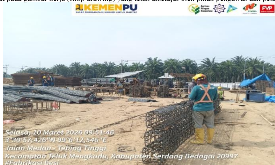
Gambar 3.1 Pengawasan Pelaksanaan Penulangan Kolom Sumber : Dokumentasi Pribadi/ camera Timestamp
