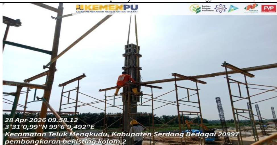
Gambar 3.5 Pengawasan Pelaksanaan Bongkar Kolom Sumber : Dokumentasi Pribadi/ camera Timestamp
