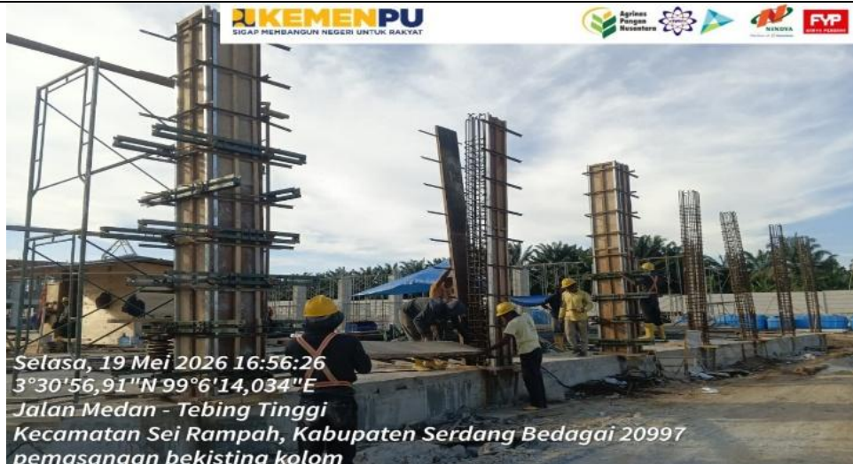
Gambar 3.2 Pengawasan Pelaksanaan Bekisting i Kolom Sumber : Dokumentasi Pribadi/ camera Timestamp
