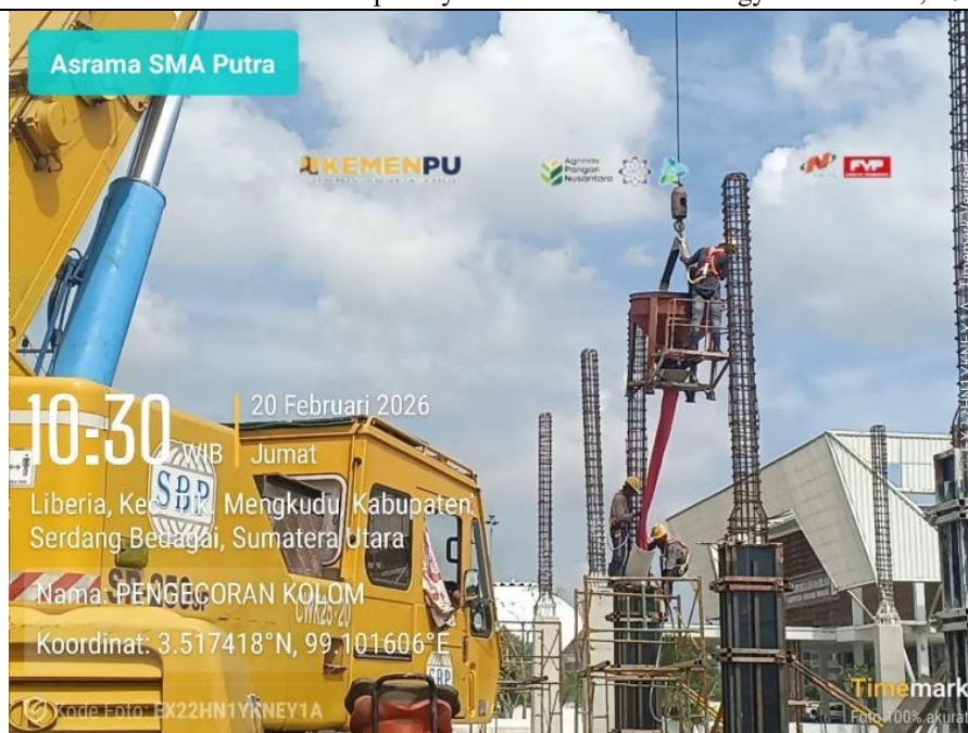
Gambar 3.4 Pengawasan Pelaksanaan pengecoran Kolom Sumber : Dokumentasi Pribadi/ camera Timestamp
