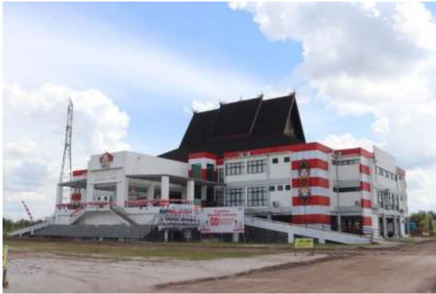
Gambar 1. Gedung Kantor DPRD Kota Palangka Raya. Sumber : id.wikipedia.org
