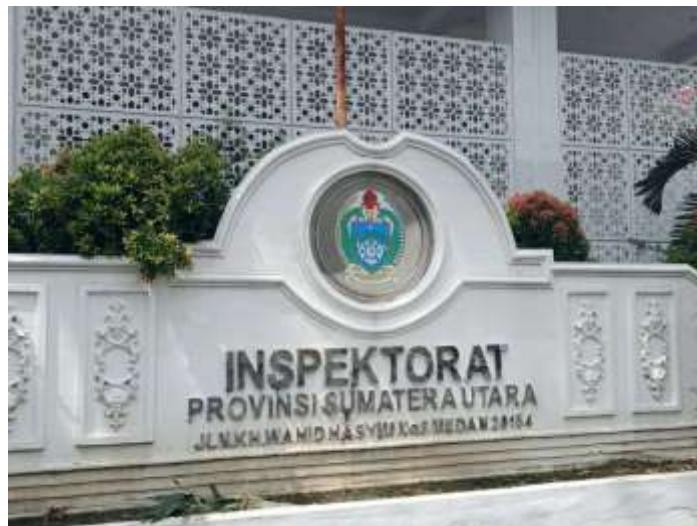
Gambar 1. Kantor Inspektorat Provinsi Sumatera Utara
