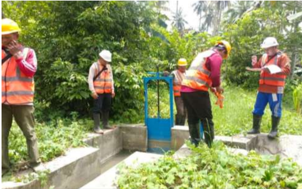
Gambar 1. Kegiatan Pemeliharaan pada Daerah Irigasi Labeau Sumber: Dinas Pekerjaan Umum dan Tata Ruang Kab. Konawe Kepulauan, 2026
