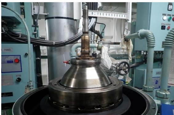
Gambar 7. Pemasangan Bowl Hood
