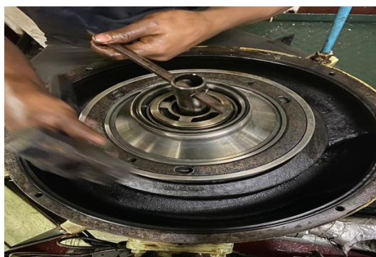
Gambar 4. Overhaul Purifier Sumber: Penulis (2023)
