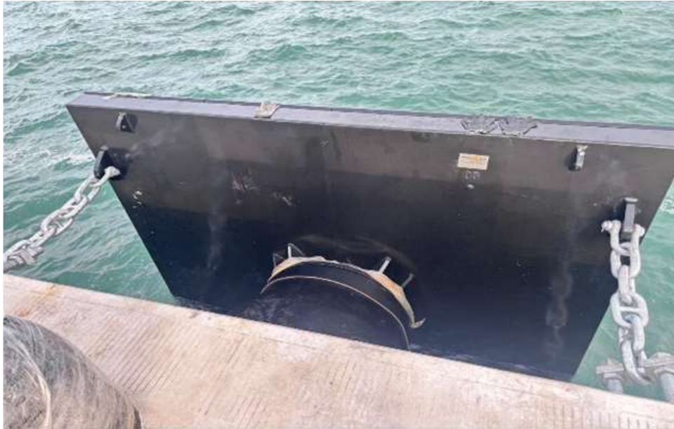
Gambar 3. 1 Kondisi Fender SPC 1300 Pelabuhan Patimban Paket 6 Sumber: Dokumentasi Pribadi (2025)
