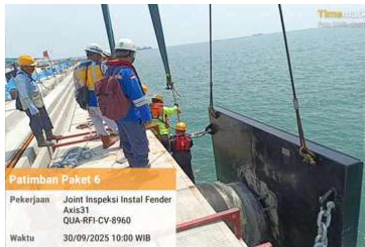
Gambar 3. 3 Proses Pemasangan Unit Fender di Area Jetty Head. Sumber: Dokumentasi Lapangan (2025)
