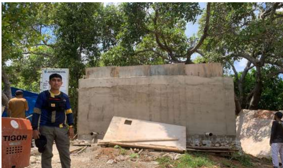
Gambar 2 Monitoring dan Evaluasi pembangunan reservoir di Kelurahan Lansilowo Kec Wawonii Utara Kabupaten Konawe Kepulauan Provinsi Sulawesi Tenggara Sumber : Data Primer (2026)
