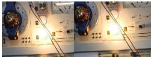
Gambar 16 Kondisi Lampu LED Saat dan Sesudah Perpindahan ATS Pada Uji ketiga
