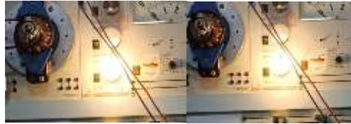
Gambar 14 Kondisi Lampu LED Saat dan Sesudah Perpindahan ATS Pada Uji Kedua
