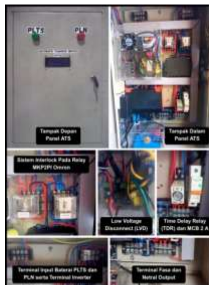
Gambar 2 Realisasi ATS dengan Sistem Interlock
