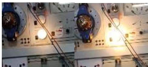
Gambar 7 Kondisi Lampu LED Saat dan Sesudah Perpindahan ATS Pada Uji Ketiga
