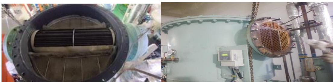
Gambar 1. Overhaul Condensor Sumber: Penulis (2023)
