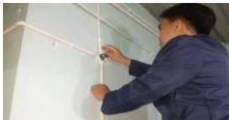
Gambar 14. Pemeriksaan Kabel dan Sambungan
