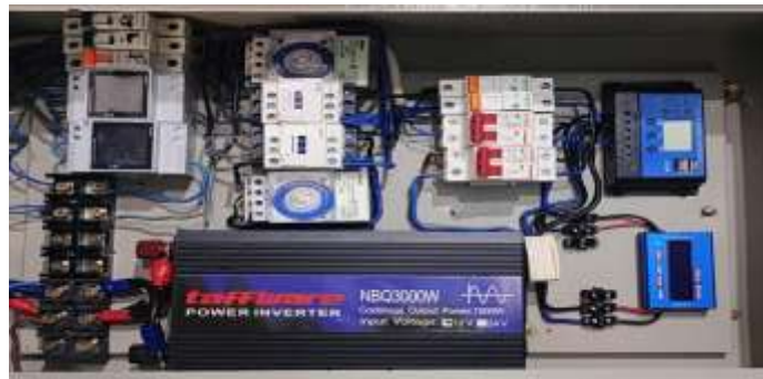
Gambar 1. Rangkaian Instalasi PLTS
