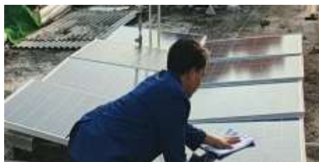
Gambar 11. Pembersihan Panel Surya
