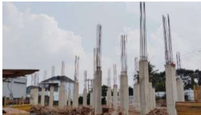
Gambar 6. Hasil Pengecoran Kolom
