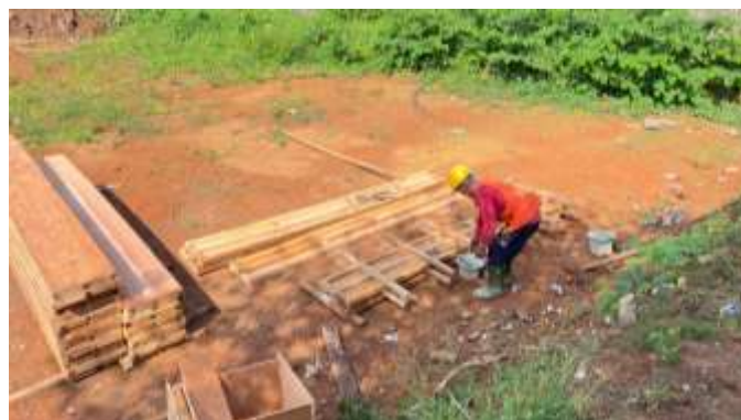
Gambar 4. Pembuatan Bekisting
