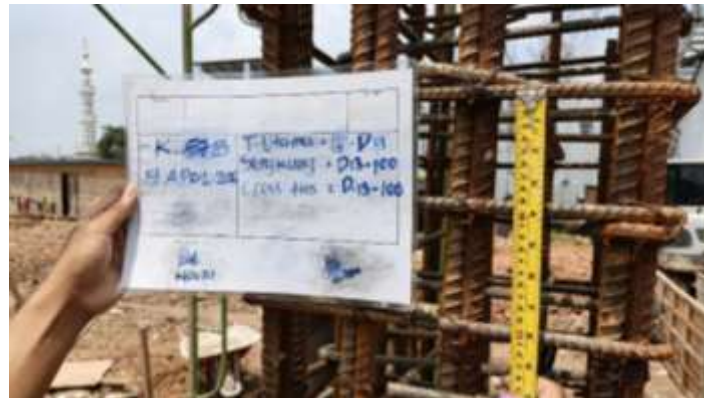
Gambar 7. Checklist pembesian kolom
