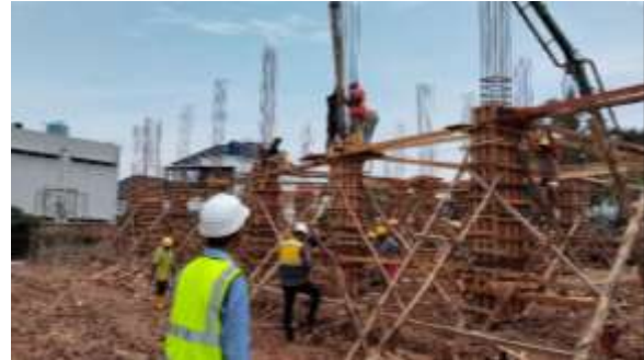
Gambar 5. Proses Pengecoran Kolom
