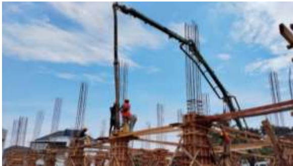
Gambar 5. Proses Pengecoran Kolom
