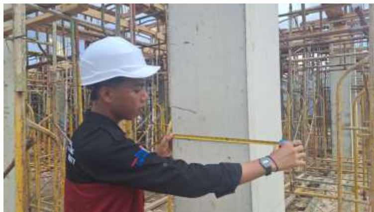
Gambar 10. Pengukuran Dimensi Kolom
