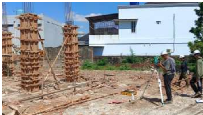
Gambar 8. Pemeriksaan posisi dan vertikalitas bekisting
